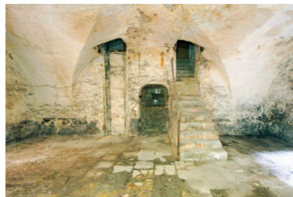
Zentralkeller (Foto: Christian Naser)
