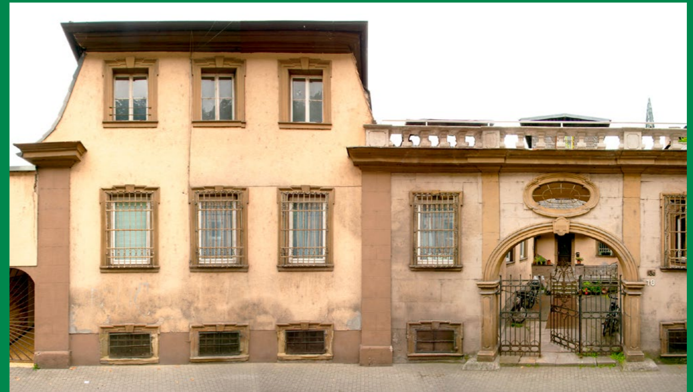
Straßenansicht mit nördlichem Seitenflügel und Tor zum Innenhof (Foto: Christian Naser)
